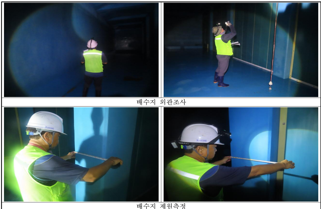
【사진 3.1】 시설물 외관조사
